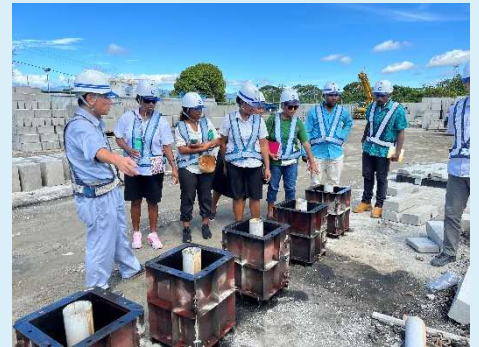
財務省によるホニアラ道路工事業のモニタリング（ソロモン諸島）
