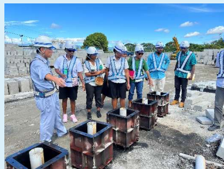
財務省によるホニアラ道路工事の事業モニタリング （ソロモン諸島）
