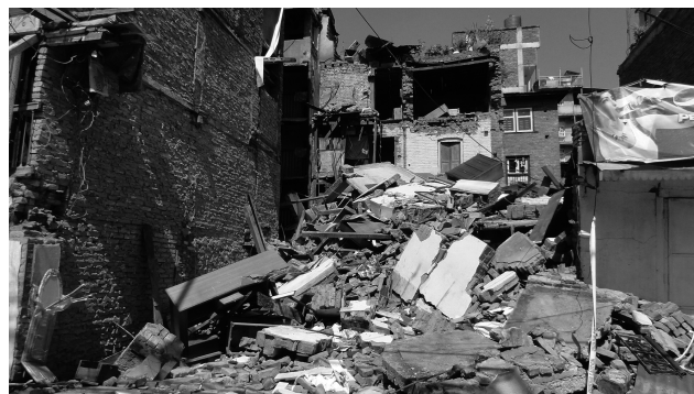
崩れた民家(ラリトプル郡)
