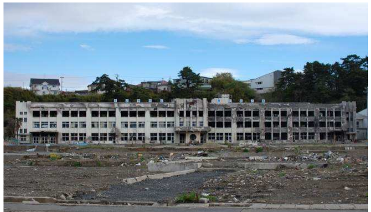
図 5-4 被災後の石巻市門脇小学校 校内に残っていた生徒全員が適切に避難した。(2012 年 5 月 5 日 筆者撮影)
